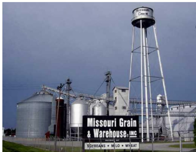
Hình 6.8. Kho Silo (Kho máy) chứa hạt
